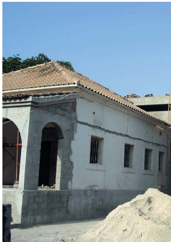
Obras na sede da ANP-STP
